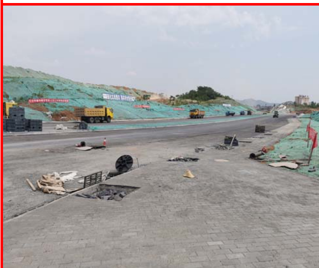
西侧秦岭大道在建工地
