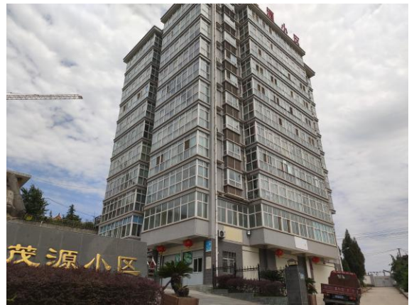
变电站北侧茂源小区
