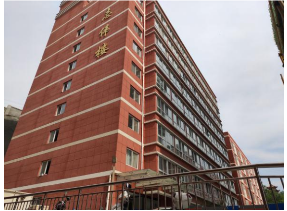
变电站东南侧安康长兴学校
