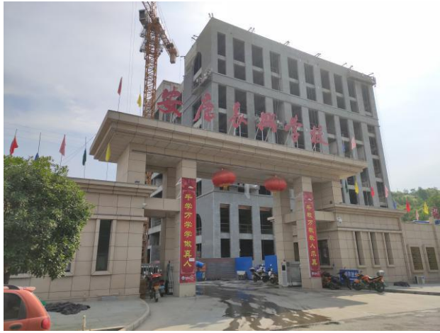
变电站东南侧安康长兴学校
